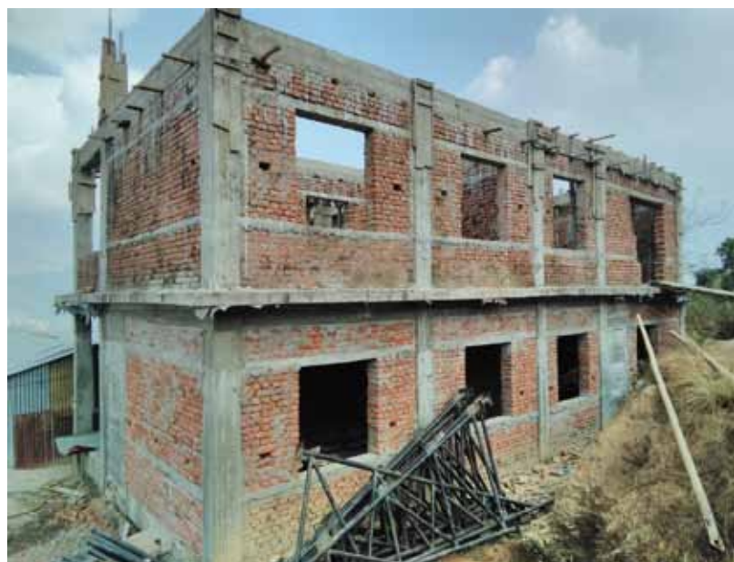
École de Balkumari en novembre 2018. Elle a été achevée en février 2019
